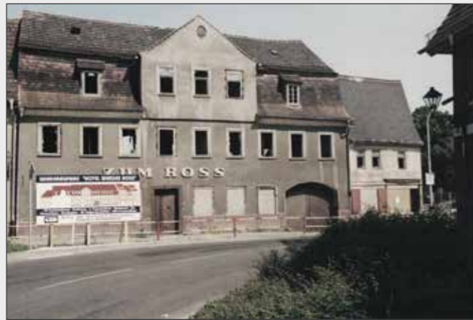
Das Hotel kurz vor seinem Abriss und Neubau Ende der 90er Jahre
